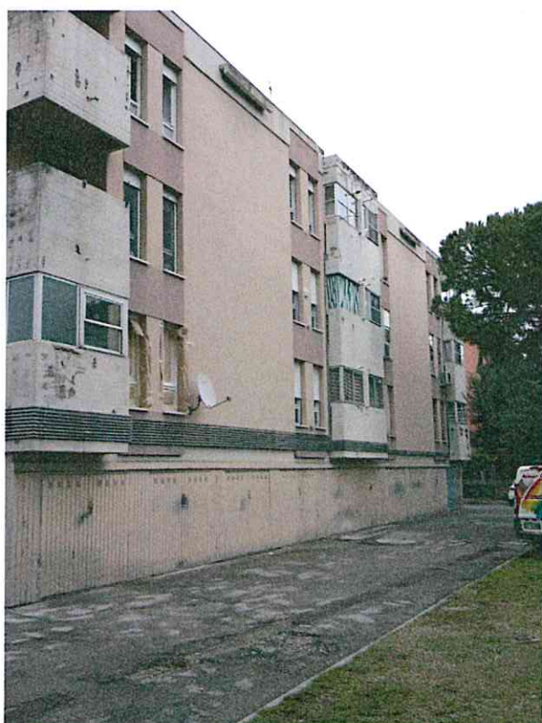
Fig. 1 Prima dei lavori
