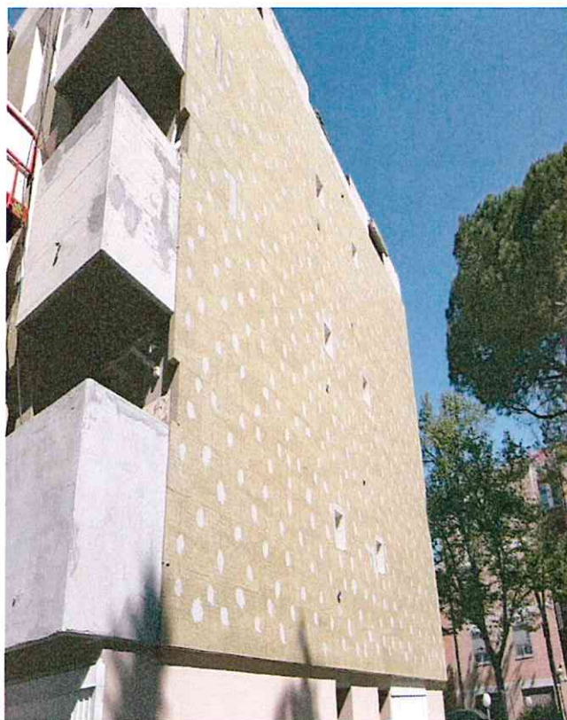
Fig. 2 Parete verticale sud in lavorazione
