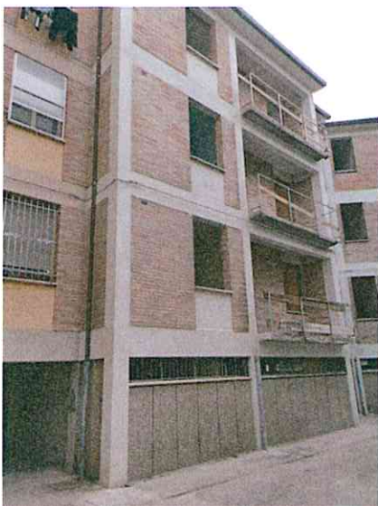
Vista dal cortile interno
